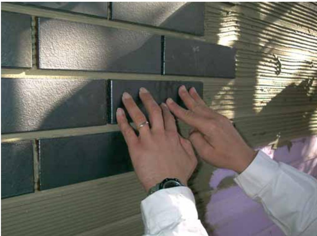
Da hierbei neben den Vorarbeiten, wie Eckgewebe ansetzen und Armierungsschicht aufbringen auch die zeitaufwändigen Standzeiten vor dem eigentlichen Riemchenansetzen entfallen, können die Fassaden deutlich schneller fertig gestellt werden.
